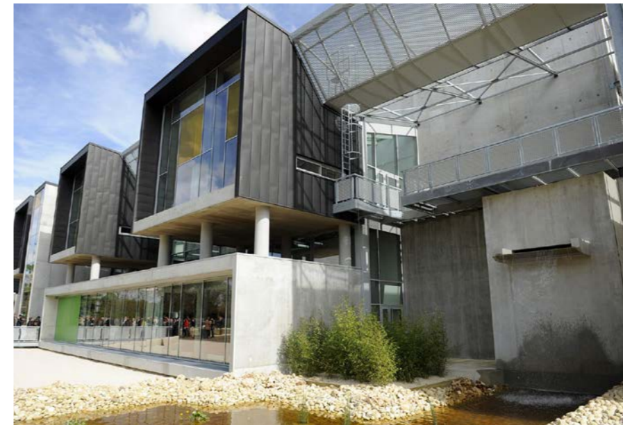
Station d'épuration Petite-Californie
