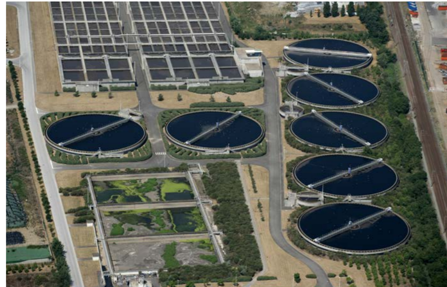
Station d'épuration de Tougas
